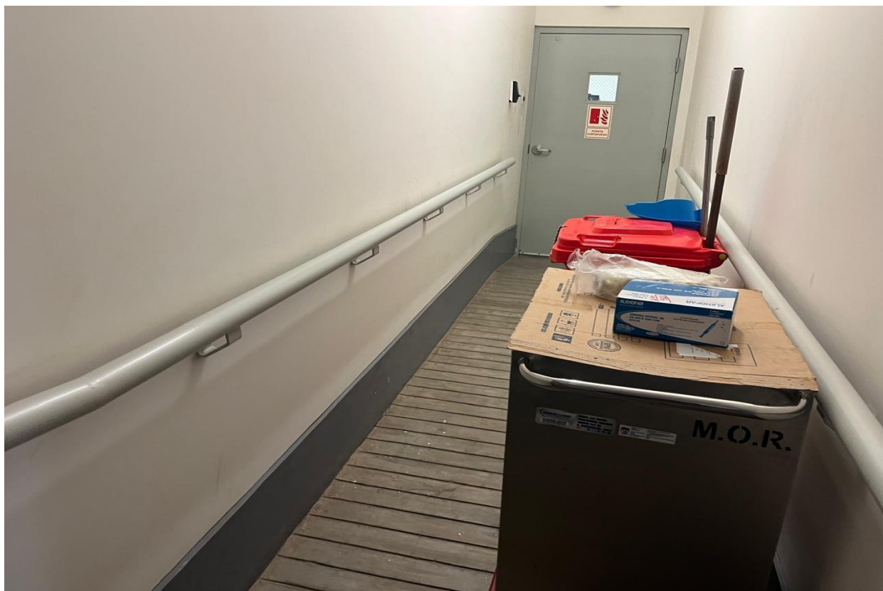
Fotografía 3: Se observa pasadizos obstruidos
