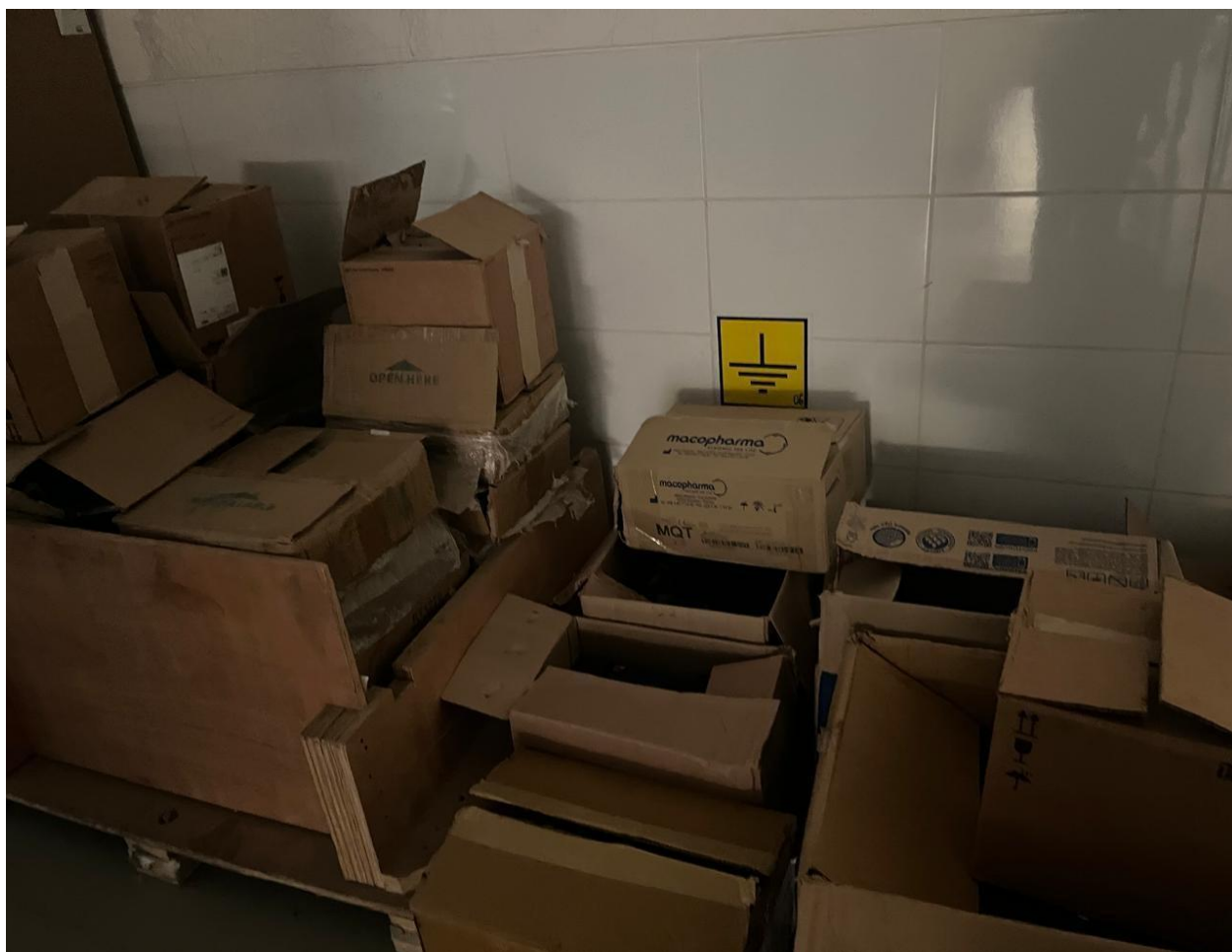
Fotografía 4: Señalización no visible, cajas colocadas en vías de evacuación.
