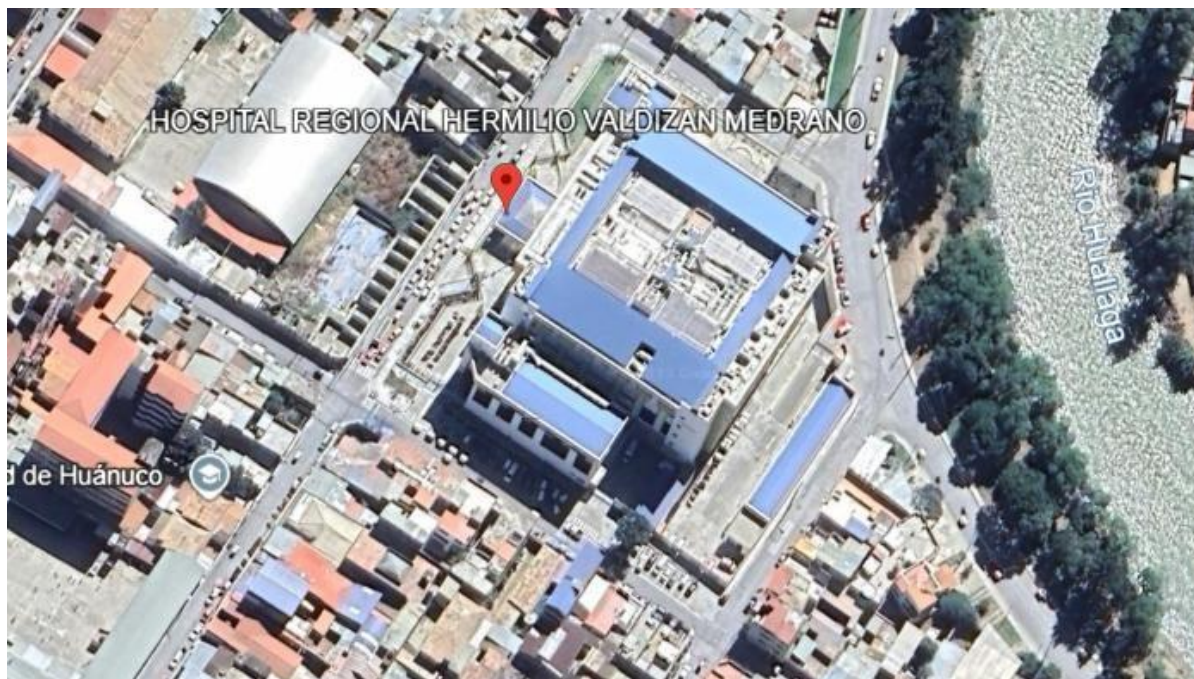
Vista Fotográfica del Hospital Hermilio Valdizan Medrano
