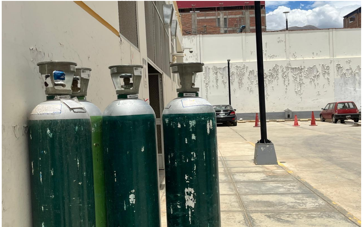
Fotografía 7: Los tanques medicinales no cuentan con abrazaderas ni sujeciones adecuadas, presentando riesgo de caída.
